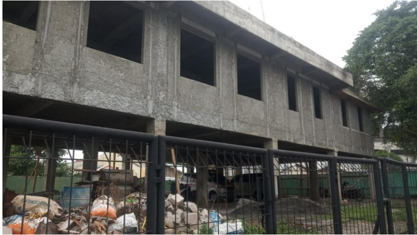
Figure 1 Proses pembangunan pondok pesantren
