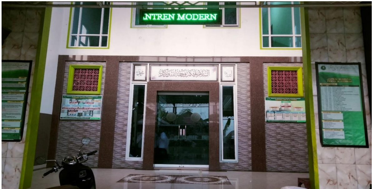
Gedung Pondok Pesantren Modren Tahfidzul Qur'an Al Fitroh
