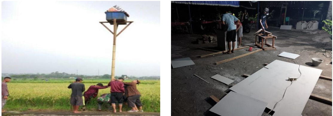
Gambar 11. Proses Pembuatan Rumah Burung Hantu
