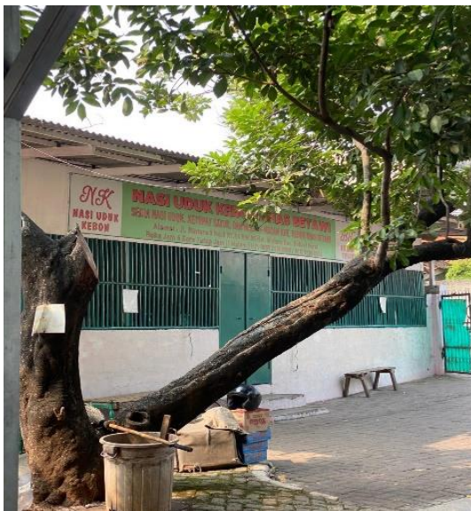
Gambar 7 Tampak depan Warkopduk Kebon
