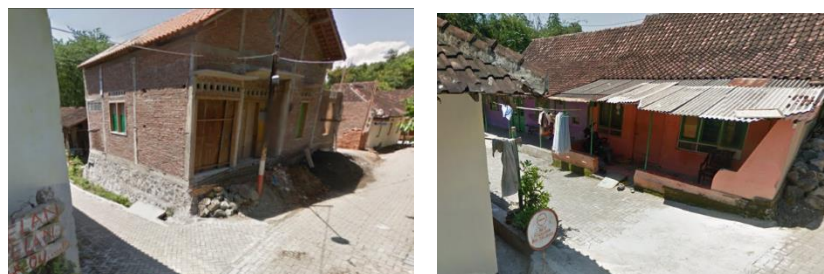
Gambar 5 Kondisi rumah sebelum direlokasi di Kawasan Jalan Kuda
