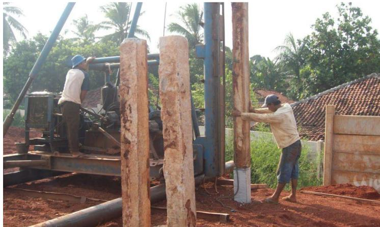
**Gambar 4.27 Pengerjaan Pondasi *Strauss Pile***
