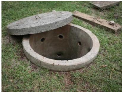
**Gambar 5. 8 Penerapan Sumur Resapan**
