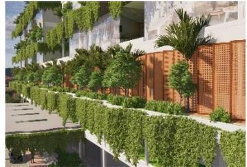
Gambar 5. 13 Sun Shading dari Material Kayu
