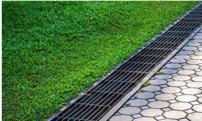
*Gambar 4. 12 Sistem saluran pembuangan (drainasi)*
