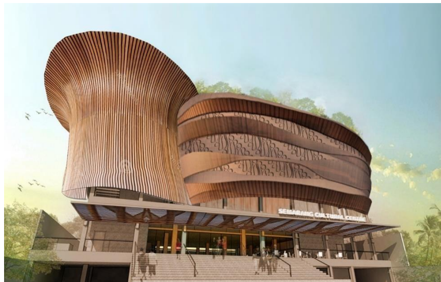
Gambar 2.2. Gedung Radjawali Semarang
