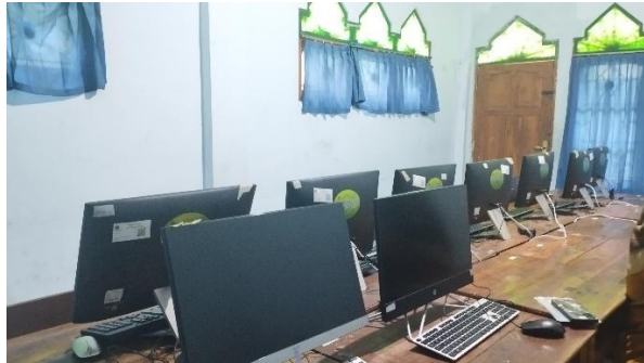
Gambar 4.9. Pemasangan Perangkat Keras
