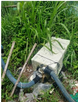
Gambar 4. 3 Mesin penyedot air limbah
