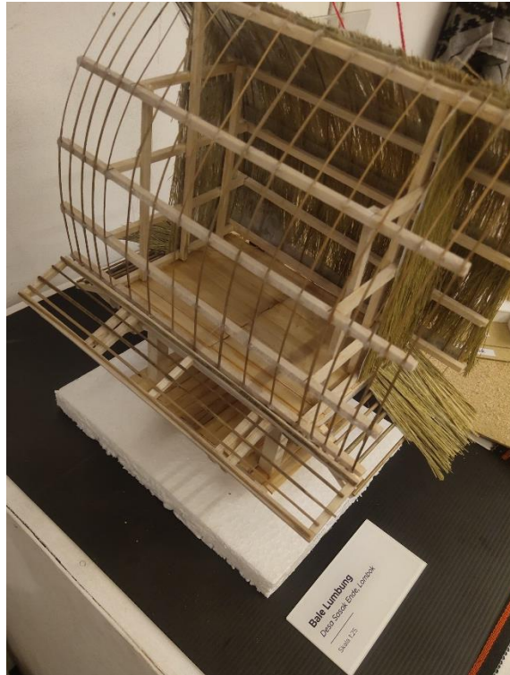
Gambar 2.9 Atap Konstruksi Bambu pada Bale Lumbung, Desa Sasak Ende, Lombok (Sumber: Pameran Sustaining Sustainability of Architecture. Universitas Diponegoro, 2024)
