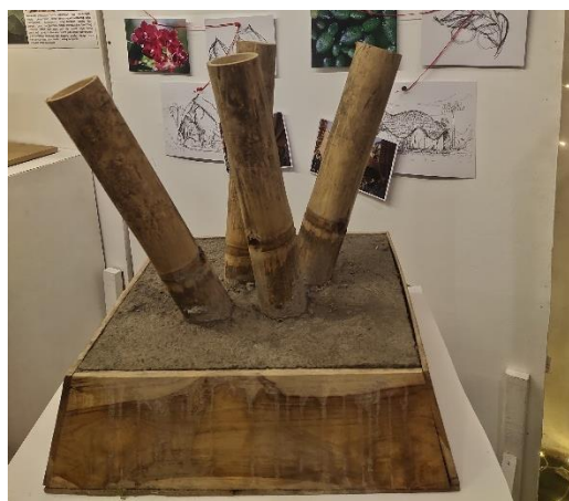
Gambar 2.7 Pondasi Konstruksi Bambu pada Bamboo Water Village, Lombok
