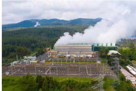
Gambar 2.5 Pembangkit Listrik tenaga panas bumi di Indonesia
