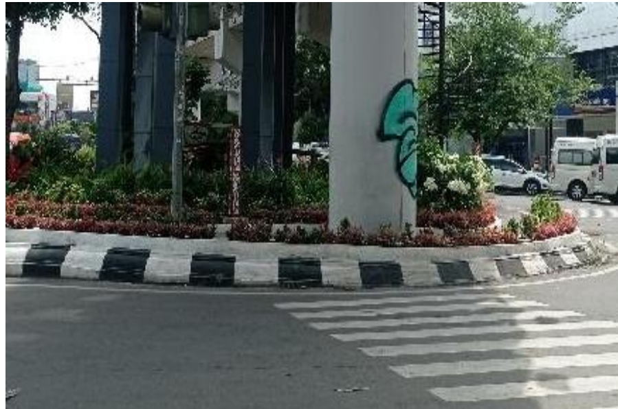
Gambar 5. 8 Zebra Cross atau Jembatan Penyeberangan
