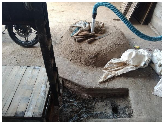
Gambar 19. Tempat Penampungan Limbah Cair dari Buis Beton
