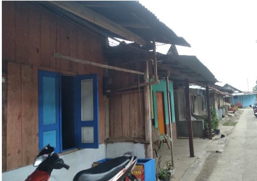
Sumber: Dokumentasi Penulis, 2024
