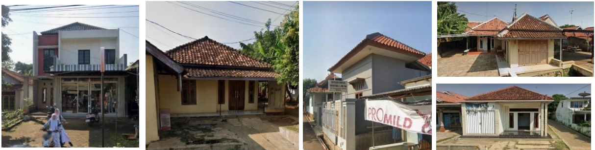
Gambar 2 28 Bangunan Rumah dengan atap limasan modern di daerah Batang (Sumber : Dokumentasi Pribadi)
