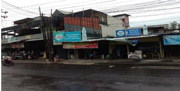
Gambar B. Kondisi rumah makan Lya Seafood tampak dari depan
