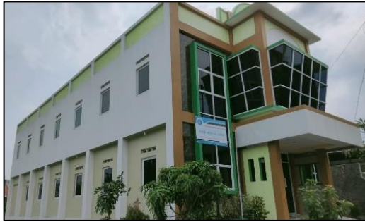
Gambar 1 Gedung Pondok Pesantren Progresif Fathimah Al Amin
