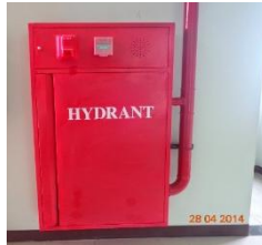
Gambar 4. 33 Hydrant indoor (Sumber: 88bangunan.co.id)
