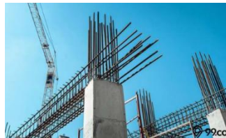
Gambar 4. 25 Struktur Beton bertulang (sumber: sindig.unesa.ac.id )
