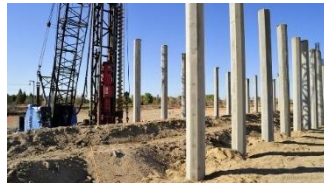
Gambar 4. 24 Substruktur Pile cap (sumber: primakonstruksi.com )
