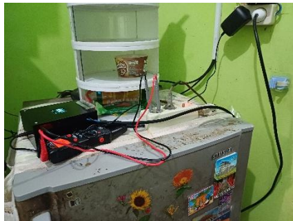
Gambar 4. 22 Pengujian tegangan Kulkas
