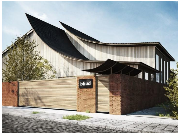
Contoh bangunan yang menggunakan atap miring melengkung
