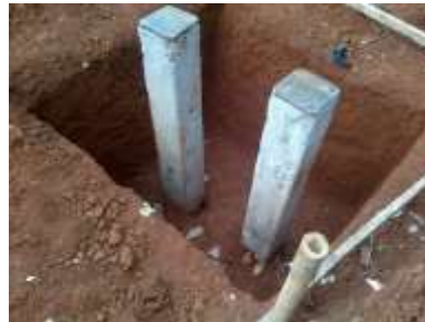
Gambar pondasi mini pile
