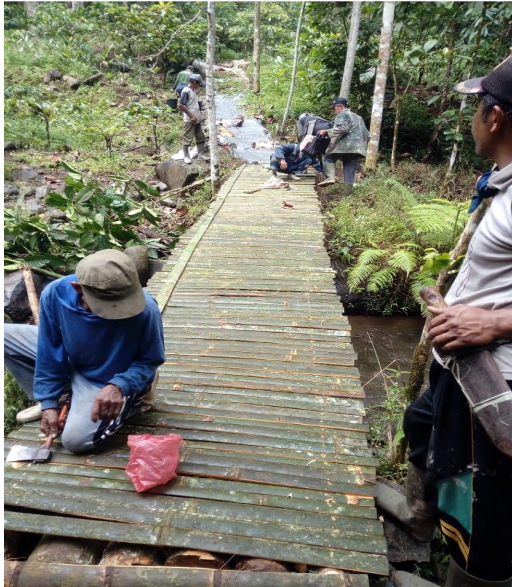
Gambar 21 Kelompok Tani Ngadukaweruh Sedang Memperbaiki Jalan
