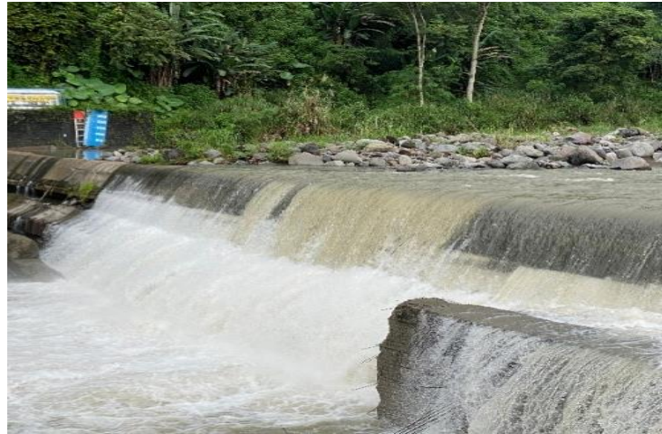
Gambar 3.7 Bendungan Kali Gung
