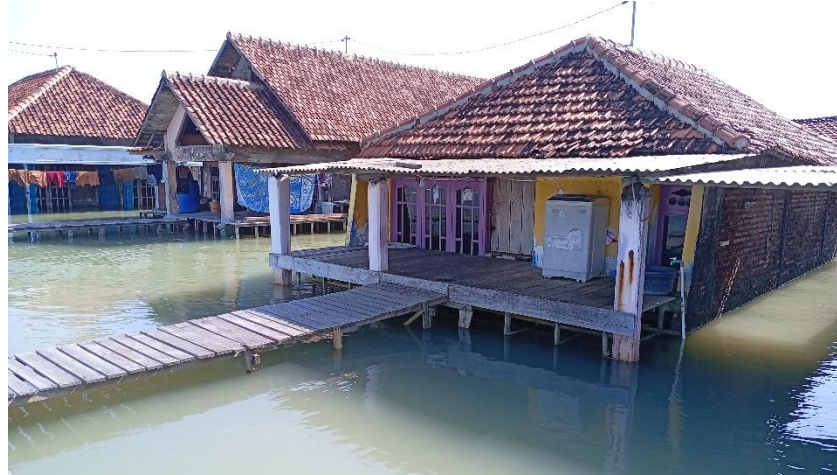
Gambar 3.23 Bangunan rumah warga yang direnovasi menjadi bangunan panggung di Desa Timbulsloko
