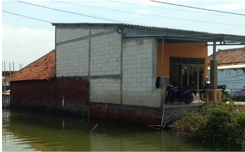
Gambar 3.22 Bangunan rumah warga yang telah selesai ditinggikan
