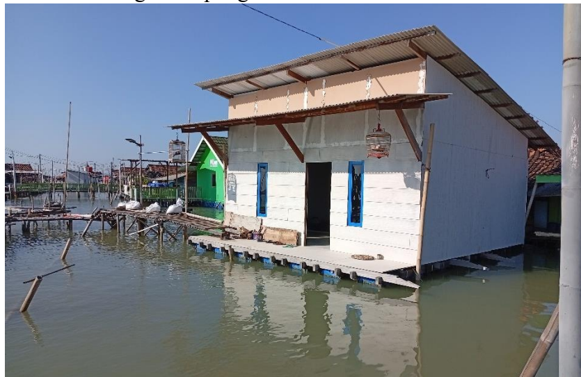
Gambar 2.24 Bangunan rumah warga yang direnovasi menjadi bangunan apung di Desa Timbulsloko
