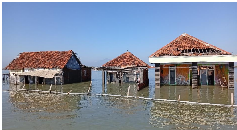
Gambar 3.11 Rumah yang terendam air secara permanen di Desa Timbulsloko
