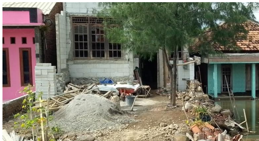
Gambar 3.15 Kondisi rumah warga di Desa Timbulsloko yang sedang dalam proses renovasi
