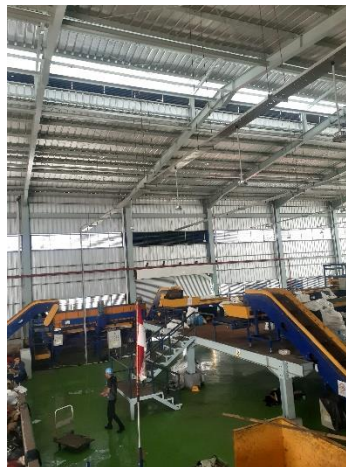
Gambar 7. Tempat Pemilahan Sampah Sumber : Dokumentasi Pribadi, 2025
