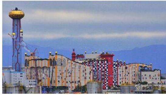
Gambar 17. Maishima Incinerator Osaka Jepang
