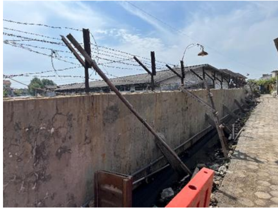
Gambar 5. Pembangunan Tanggul Permanen oleh Pemerintah
