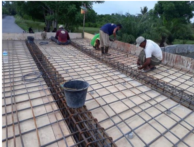
Gambar 4.18 Sistem Pemasangan Plat Lantai
