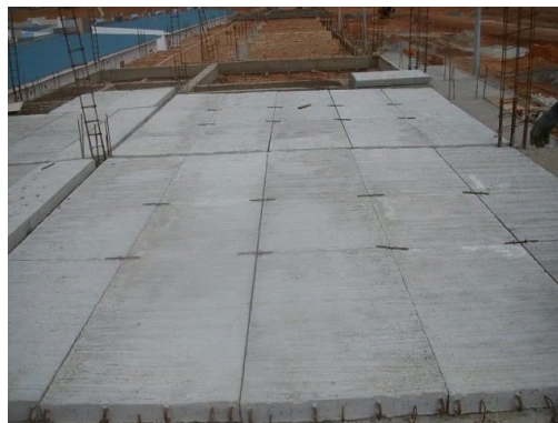
Gambar 2. 23. atap dak beton (sumber : pinterest)
