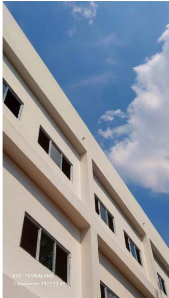
Gambar 2. 3. Gedung B Sumber : (foto pribadi magang)
