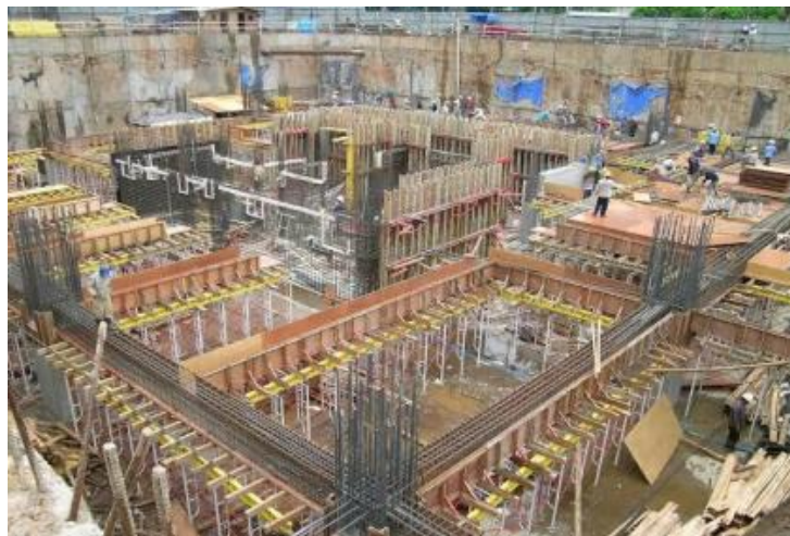
Gambar : Struktur beton bertulang
