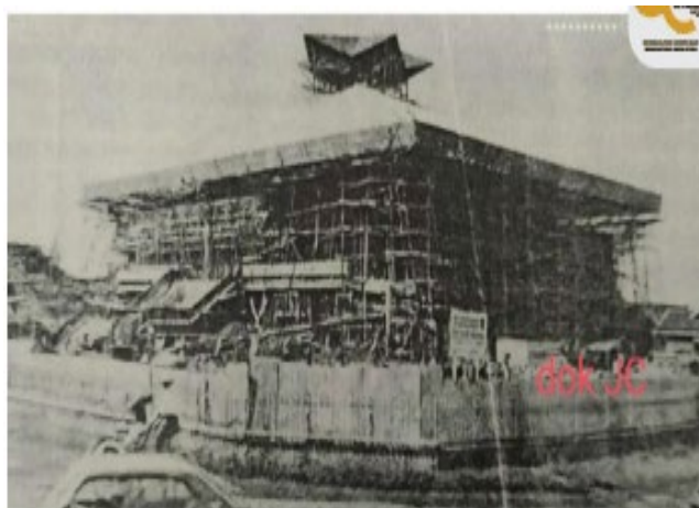
Gambar 3. 2 : Foto pembangunan masjid
