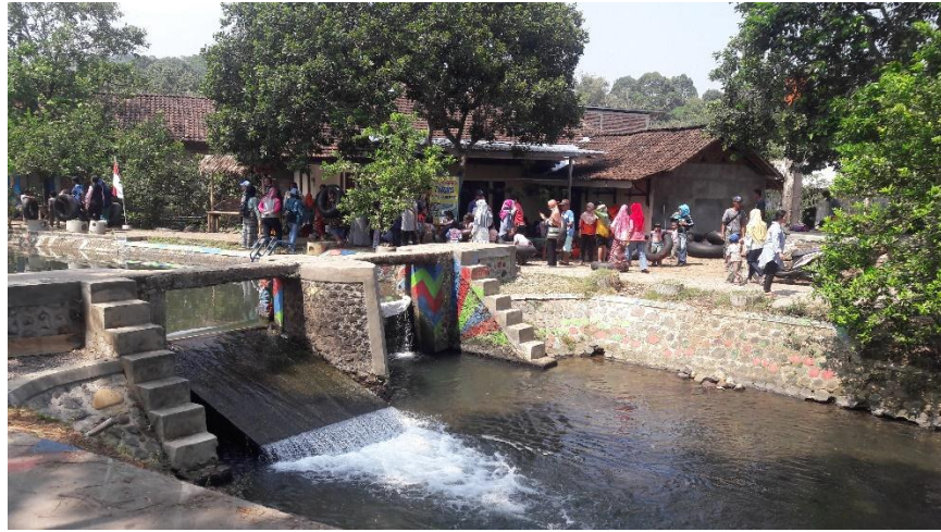
Aliran sungai yang sudah bersih dari sampah dan limbah rumah tangga
