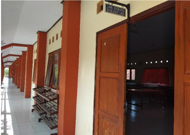
Gambar 4.1. laboratorium biologi SMA N 2 Kendal tampak dari depan
