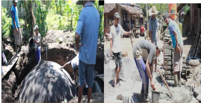
Gambar 3.8. Gotong royong pembangunan instalasi biogas
