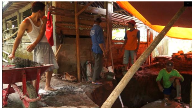
Gambar 4.1. Pembangunan digester biogas
