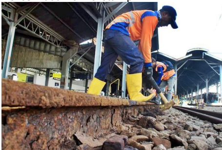
Gambar 1: Korosi pada rel kereta api
