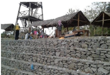
(Proses pembangunan angkringan)
