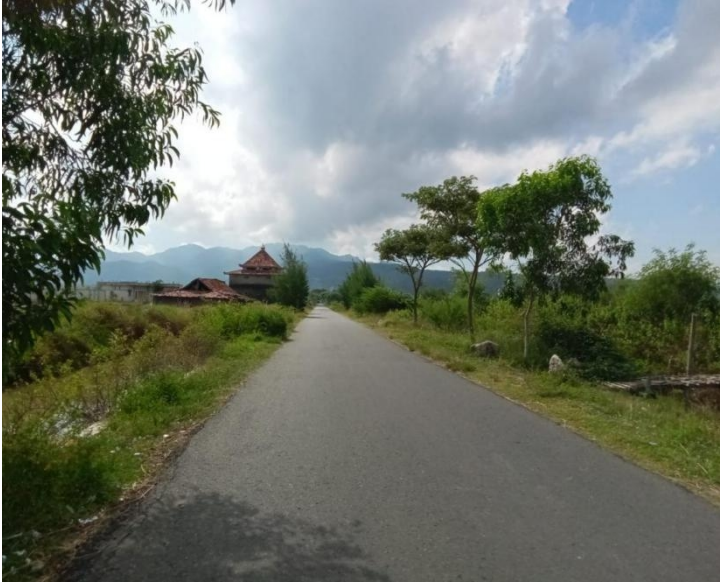
Jalan Desa Dasun/ Jalan Cinta
