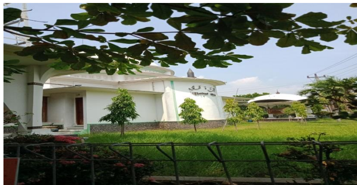
Bangunan Masjid Baitul Haq Tampak Belakang
