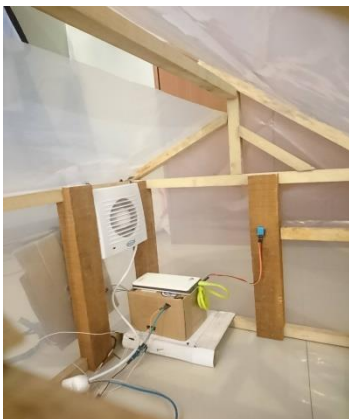
Gambar 3. Pemasangan Sensor dan Aktuator
