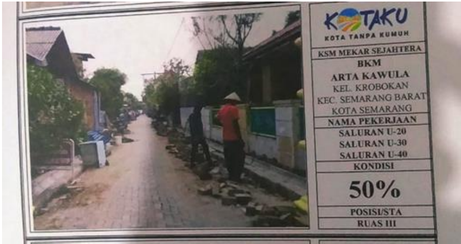
Gambar 3.5 Pembuatan saluran selokan Kelurahan Krobokan
