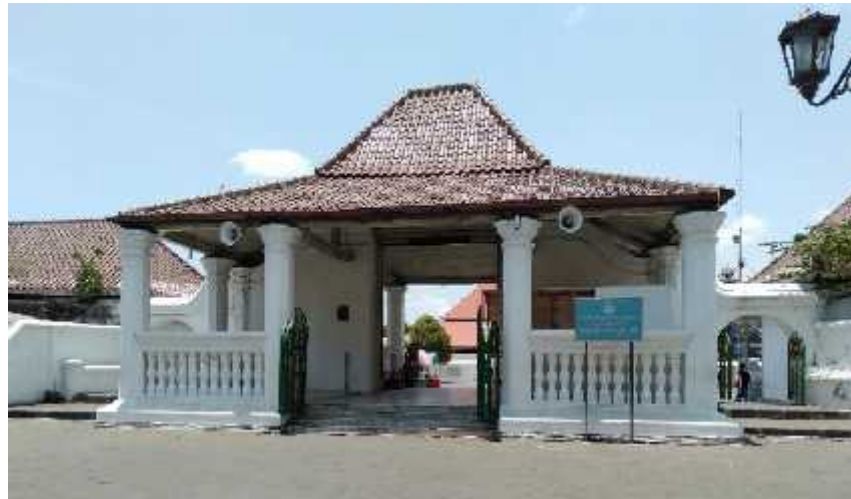
Gambar 3.49 Gapura dan Pagar Keliling Masjid Agung Yogyakarta.
