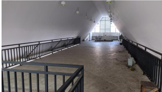
Gambar 1.6.: Kondisi ruang lantai 2.
