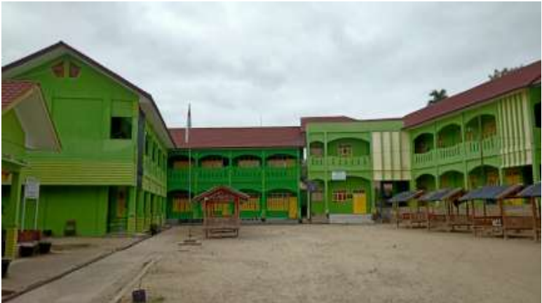
Gambar 4.1. Gedung Kelas SDIT Bunayya
