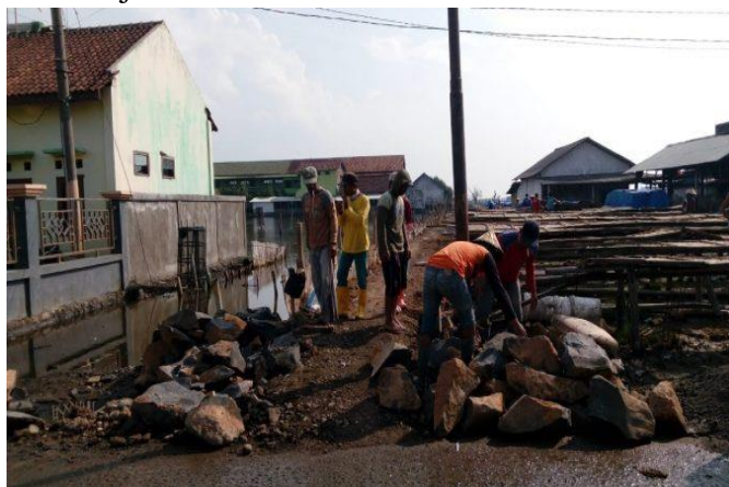
Gambar 7 : Pelaksanaan pembangunan tahun 2021
