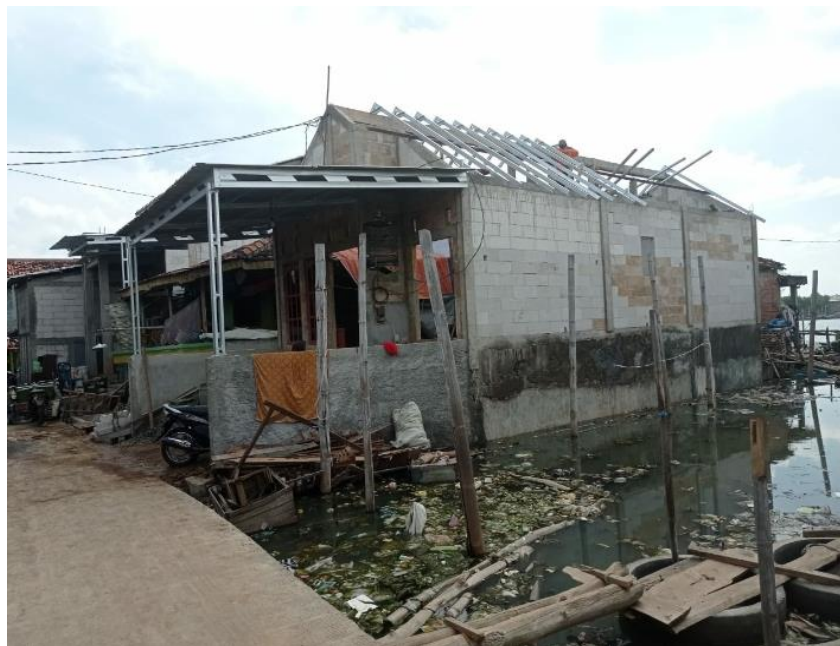
Gambar 5 : Rehabiltasi RTLH RT 2 RW 1
