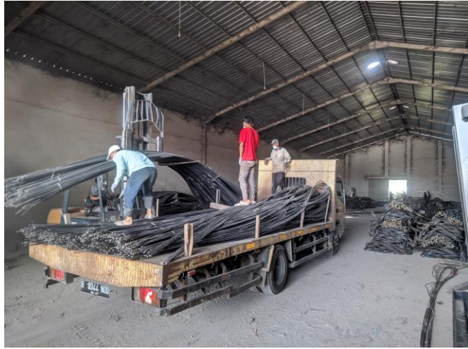
Dokumentasi Situasi dan Kondisi PT. Madeg Pilar Prayoga Kota Tegal Bagian Dalam
