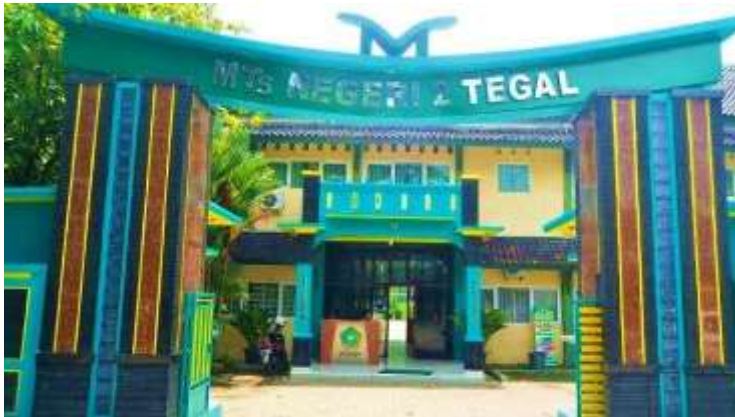
Gambar 1 Gedung MTs N 2 Tegal
