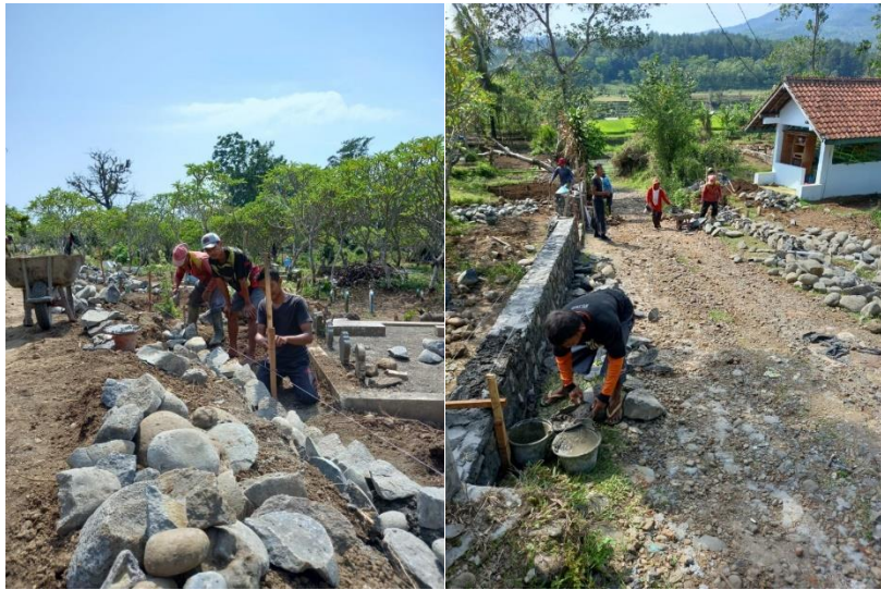
Gambar 18 Pembangunan Infrastruktur Era Imam Purkendi
